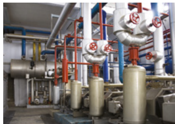
Foto: Tyco AquaMist er egnet i industrielle områder og på fabrikker.
